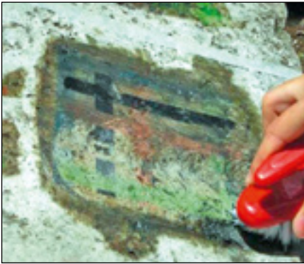
Abb. 6: Graffiti-Bürsten-Reinigung von Römischen Travertin
